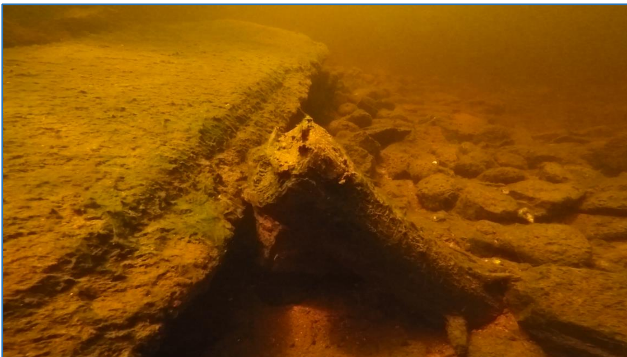
Kuva 6. Laiturin edustalla sijaitseva tolppa ja sen vieressä kivi- tai betonilevy.
