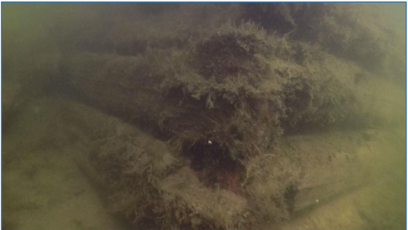
Kuva 26. Arkun kulmien salvokset ovat säilyneet ehjinä puuttuvia ylimpiä kerroksia lukuun ottamatta.
